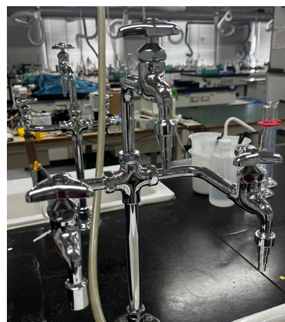
更新後の水道
