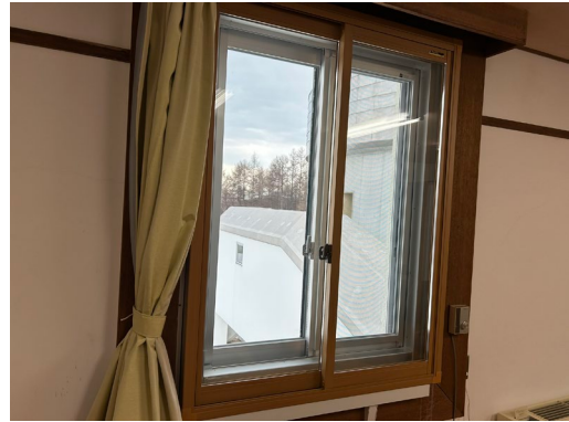
サッシ改修状況
