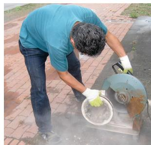
図 4c 大径刃で切断
