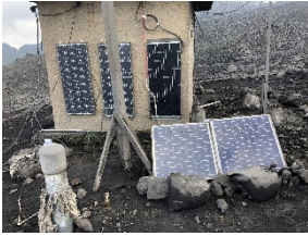
図 10 ソーラーパネルの移設
