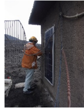
図 11 ソーラーパネルの設置
