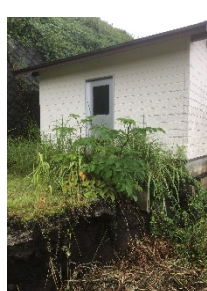
図7 トンネル前室
