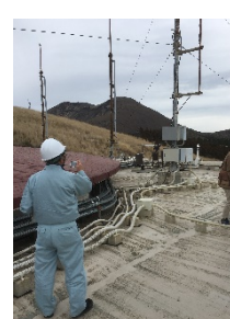
図8 博物館屋上工事打ち合わせ
