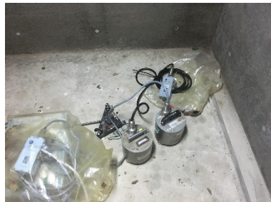
図 11 地震計の交換
