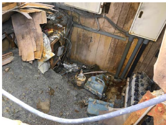
噴火により被災した観測室内部
