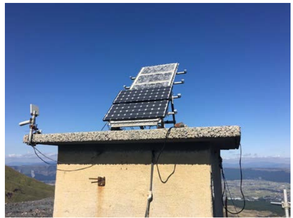
噴火に伴うソーラーパネルの破損状況と新規設置後の様子
