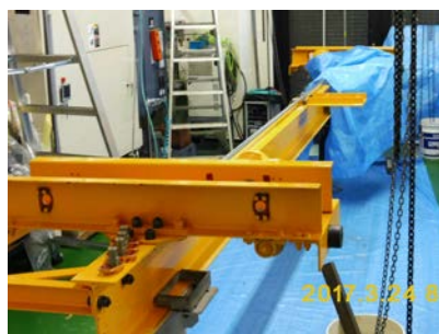
クレーン電動化工事作業
