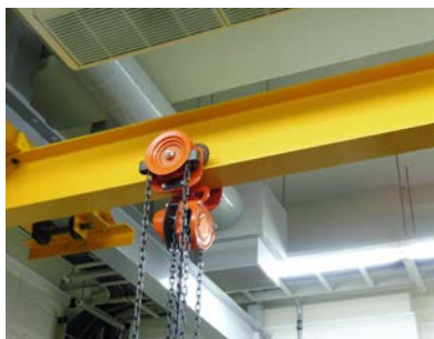
工事前の手動クレーン
