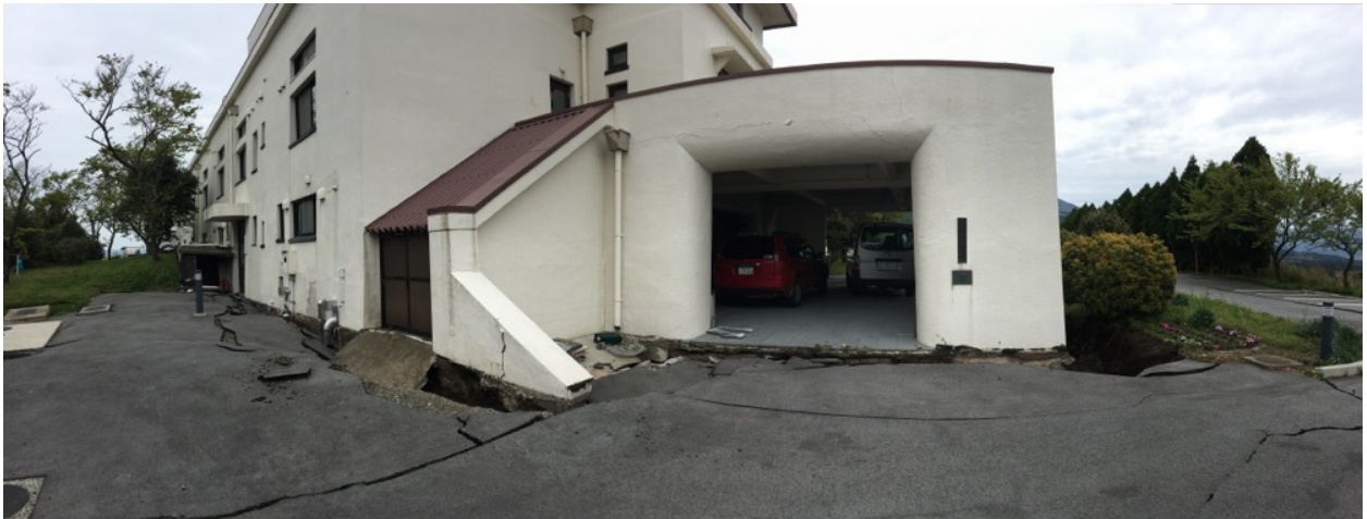
本館とアスファルトの間には数mの空間ができ建物内部は不等沈下を起こして床が盛り上がっていた
