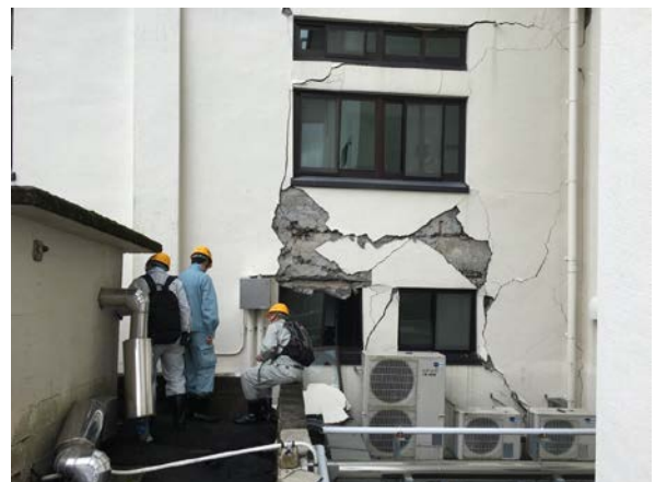
本館壁面には亀裂が入り一部剥離
