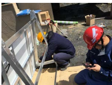
図 3. ソーラー架台組立・設置
