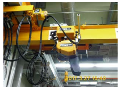
工事後の電動チェーンブロック
