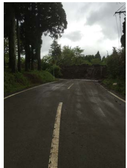
図 2. 研究所入口（土砂流出）
