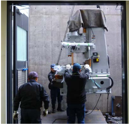
ドライエリアからクレーンで下ろされる新しいフライス盤
