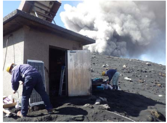
火口東観測点におけるソーラーパネル設置と コーティングの様子
