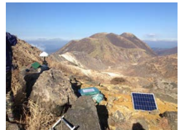
設置後の様子
