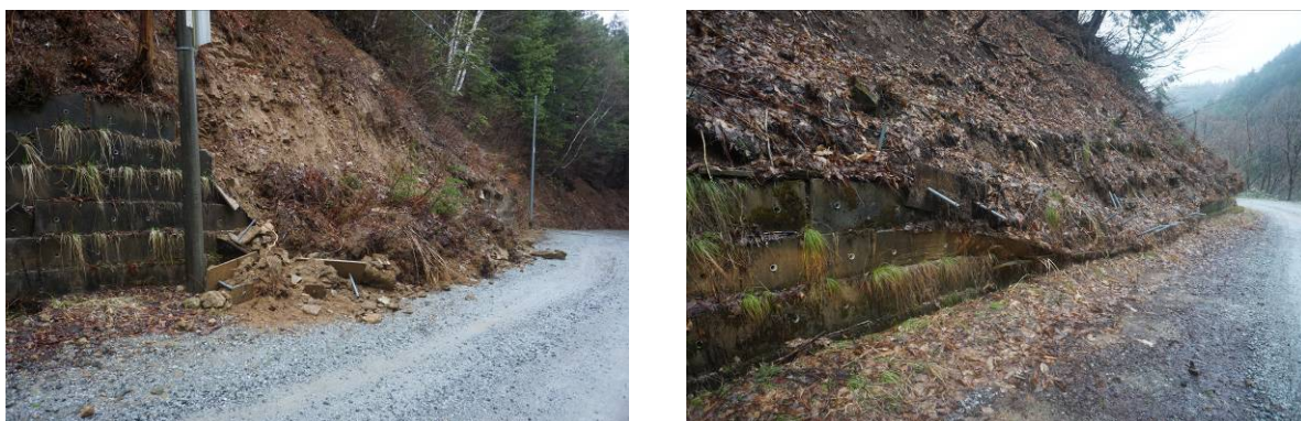
例年になく積雪により、その重みに耐えきれず崩落した法面
