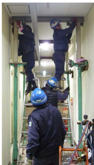
吊り上げ用檣の組み立て
