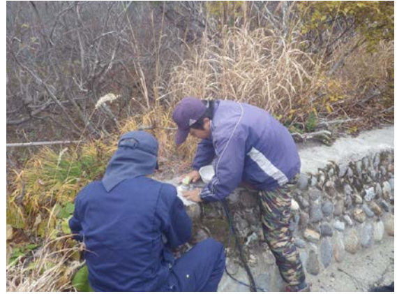
石膏を使って地震計を設置
