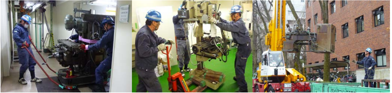
一般工場用フライス廃棄作業
