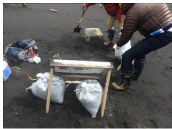
図 9. ソーラー架台の補強
