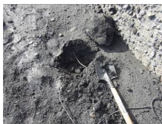
図 6. ケーブル切断
