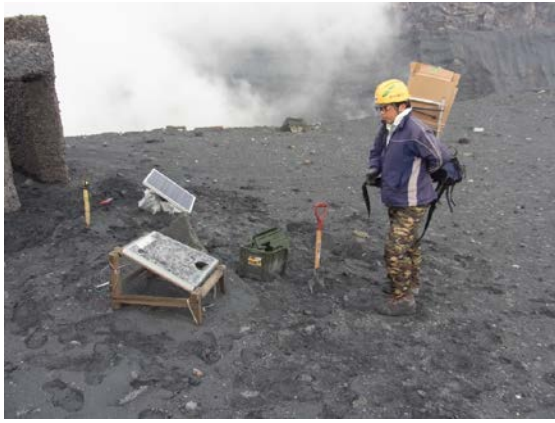
噴石によって破壊されたソーラーパネル（手前） 新たに設置したソーラーパネル（奥）
