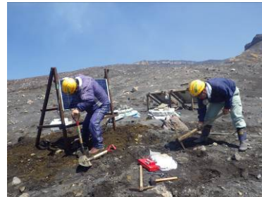
図 3. ソーラー設置 2 (架台)
