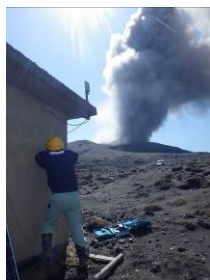
図 2. ソーラー設置 1(壁、左：穴あけ中、右：取り付け後)
