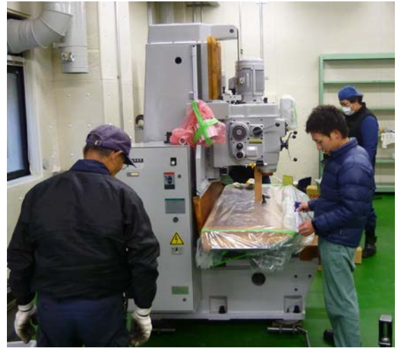
フライスの設置位置決め作業。テーブルが前後左右に動くためストローク分空けて設置するまたメンテナンス時のスペースも考慮する。
