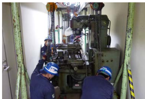
フライス吊り上げ作業
