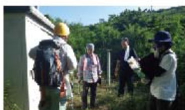
Pic. 16 地震計通信機器メンテナンス作業
