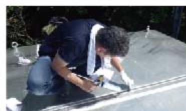
Pic. 18 地震計設置小屋の雨漏り修理
