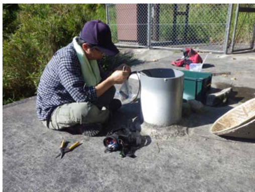
地震計ケーブルの断線補修
