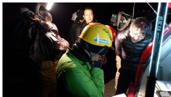
公開発破点にて発破作業の準備を行う様子
