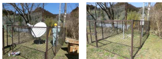
VSAT 撤収作業の様子
