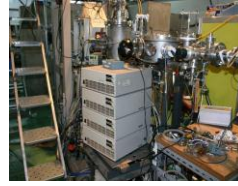
電磁石電源、制御室からリモート制御を行う
