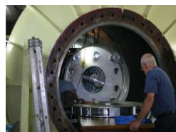
端からユニットを外して搬出
