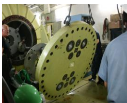
タンク平板の取り外し
