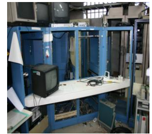
各装置を取り外し後のラック
