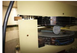
振分け電磁石真空容器の取り外し作業、まず始めに真空容器を抜くスペースを、油圧ジャッキを使って作る
