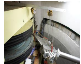
2台のチェーンブロックで下した後、放射線測定を行った
