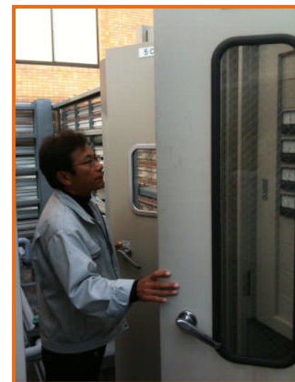
電気・給排水・循環水・建物管理全般
