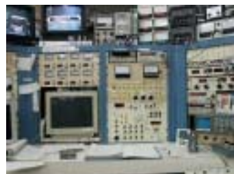
自作の制御盤
