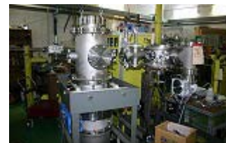
学際用 散乱槽の設置
