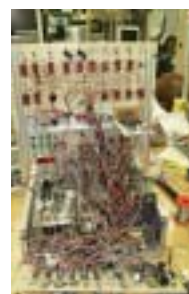
自作の制御盤配線
