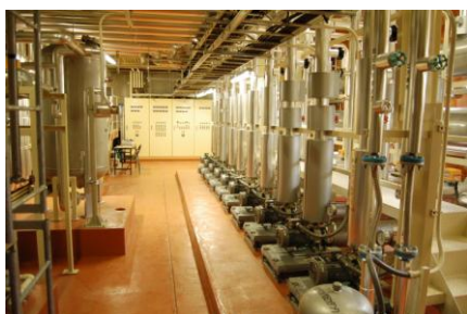
図-9 (DST 棟機械室内ブラインポンプおよび制御盤)
