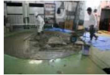
コンクリート打ち
